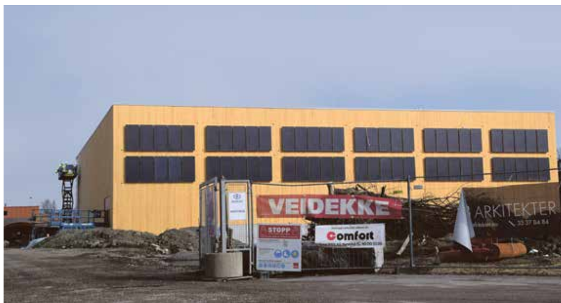
NYE ENERGILØSNINGER: Sol- og jordvarme varmer opp bygningsmassen. Strøm er bare en back-up.
